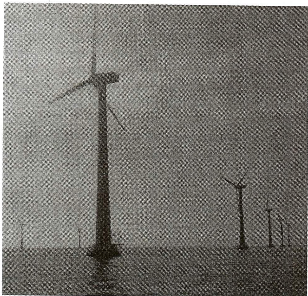
Parc éolien en pleine mer au Danemark
